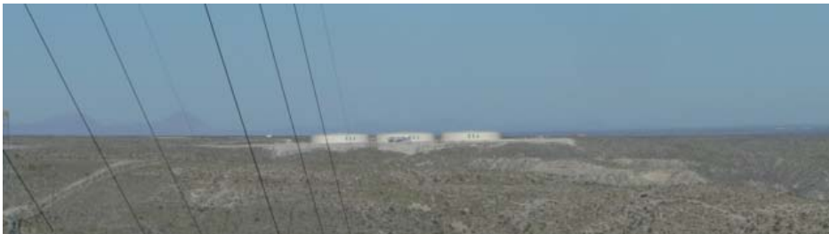
TANQUES DE ENTREGA ACUEDUCTO CONEJOS -MEDANOS
